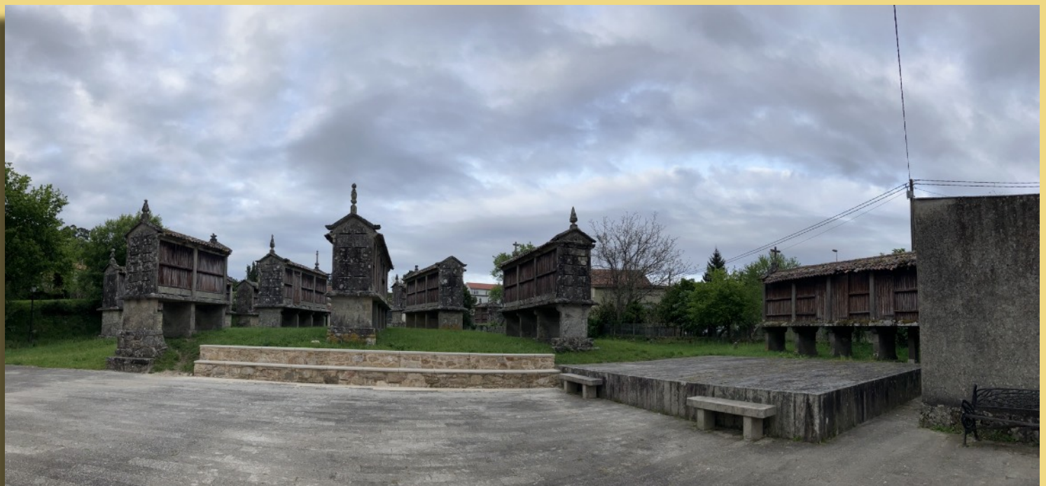
Conxunto de hórreos situado aos pés da plaza da Lavandeira, que era unha antiga eira de trillar. Nada máis entrar chama a atención a ubicación das casas, que rodean a plaza dando unha sensación de seguridade e recollemento moi agradables.
