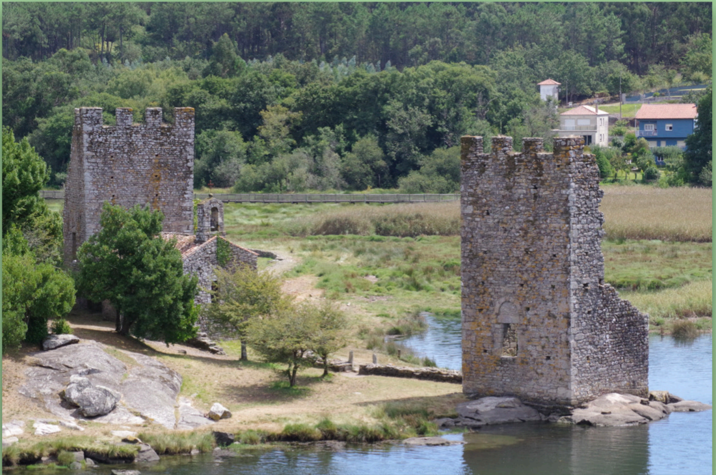
Vista das Torres do Oeste desde o lado de Isorna da Ponte de Catoira. Isorna existe, míraa en pé sobre estas torres.
